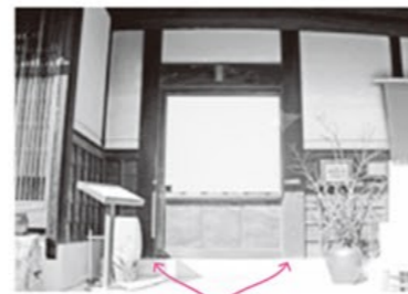
柱部分の建材は、1本のケヤキの丸太を縦に二つに割って作られたもの。そのため木目が左右対称になっています。贅沢ですね。
